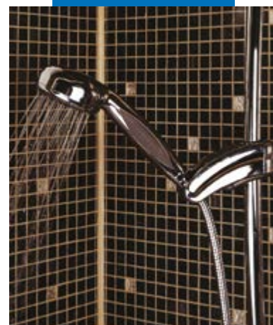
Voorbeeld van een glasmozaiek-chip coating afgevoegd met Ultracolor Plus in een douche cabine
