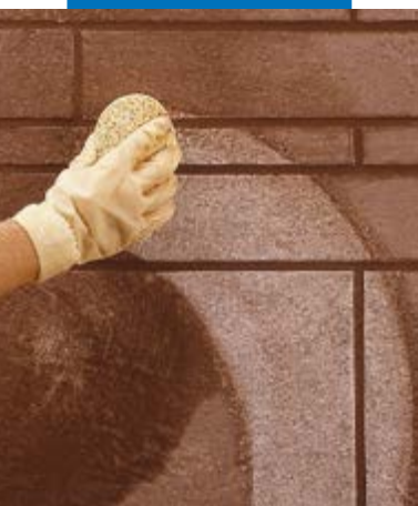
Schoonmaken en afwerken van tegelvoegen met een spons
