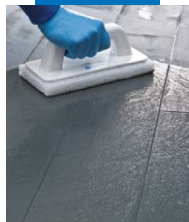
Reinigen van de voegen met een Scotch-Brite spons (wanneer het product half is uitgehard)
