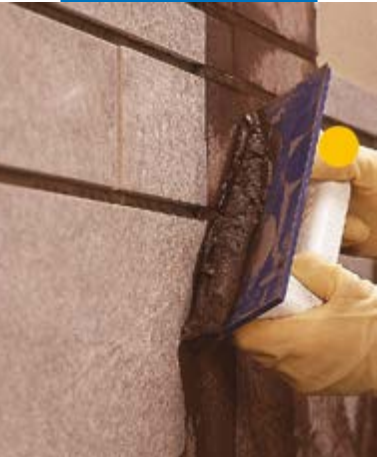
Aanbrengen van Ultracolor Plus op een muur met een voegrubber
