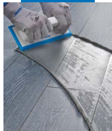
Verspreiden van Ultracolor Plus op hout-effect porseleinen vloertegels met een rubberen spaan
