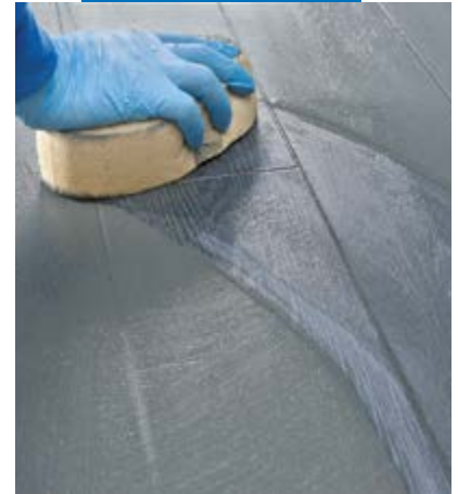
Reinigen en afwerken van voegen met een cellulose spons
